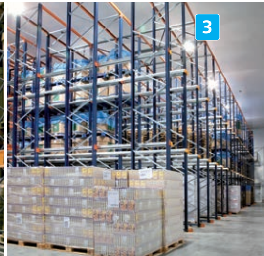
Las estanterías compactas permiten almacenar productos monorreferencia y que permanecerán largo tiempo almacenados.
