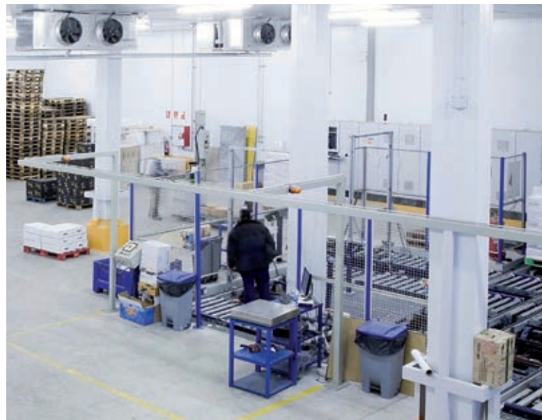
Operaciones de picking sobre la cabecera de un almacén automático.
