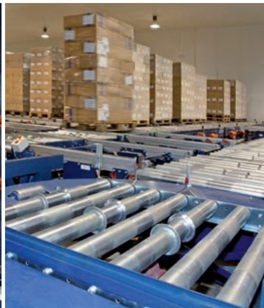
Transportadores de zona de precarga.
